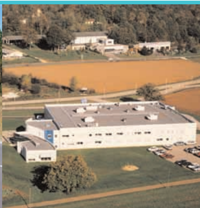
Terrains en bordure de la D.704 à Marcillac Saint Quentin pressentis pour accueillir une zone d'activités économiques.
