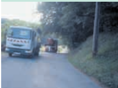
Entretien de la route de "La Croix d'Espit" à Sarlat
