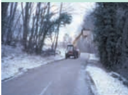
Intervention sur la route du Pech Mortier à Marcillac Saint-Quentin.
